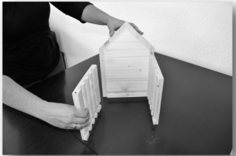
4. Schritt: Seitenteil 3 mit Rückenteil 1 verschrauben.
