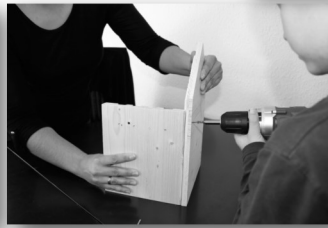
3. Schritt: Rückenteil und Seitenteil 2 verschrauben.
