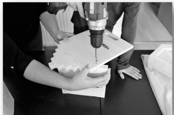
Tipp: Darauf achten, dass das Dach passgenau sauber gefügt ist! Erst dann verschrauben.
