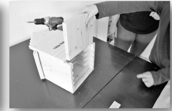
11. Schritt: Boden mit der Mulde nach innen in die Fuge einschieben, sodass die Innenteile nicht mehr verrutschen können.
